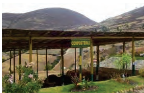
Planta de tratamiento de la Municipalidad distrital de Baños del Inca, Cajamarca (5)
